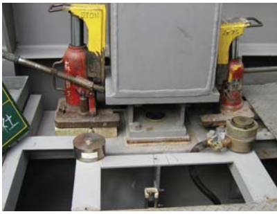
振れ止め金具取り付け例
